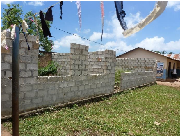
SECUNDAIRE SCHOOL MUUNGONI
